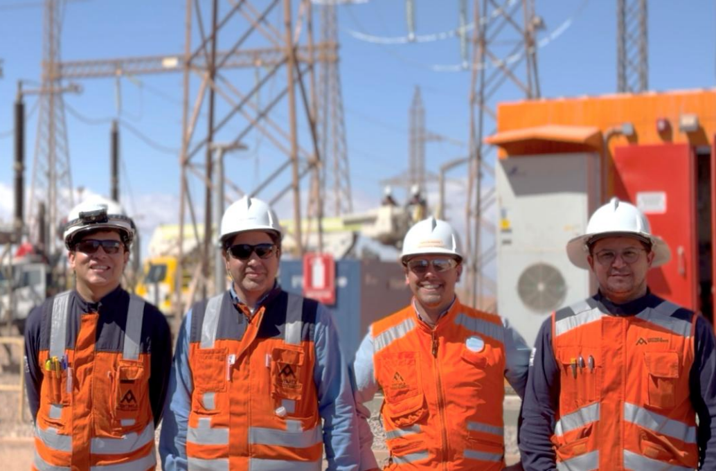
Energización Subestación Antucoya Marzo 2026
